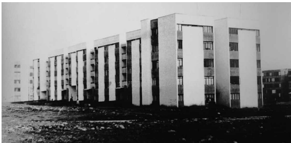
Figura 6: Edificio de 5 pisos sector 6 del conjunto Remodelación San Luis
